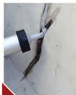
OBERFLÄCHEN- SANIERUNG Oberflächensanie- rung in Asphaltbelägen z.B. starke Netzrisse oder Schläglöcher
