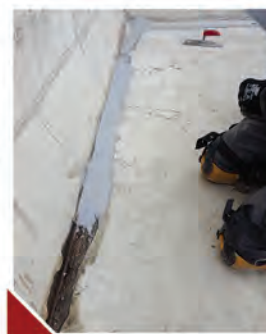
FUGEN Fugenherstellung und Sanierung im Heißverguss-Verfahren
