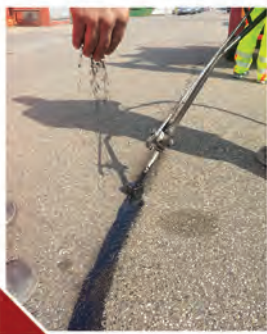
RISSESANIERUNG Rissesanie- rung im HPS-Verfahren auf Asphaltbelägen
