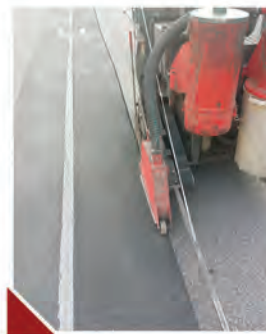
RISSESANIERUNG IM FRÄSVERFAHREN Rissesanie- rung im Fräs-Verfahren auf Asphaltbelägen
