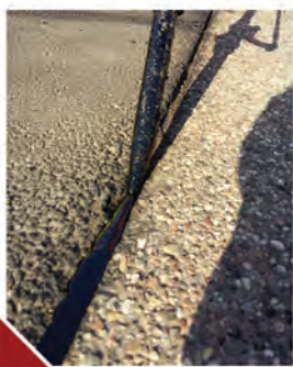
FUGEN Fugenherstellung und Sanierung im Heißverguss-Verfahren
